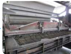
Загрузка бетона в установленную насадку
