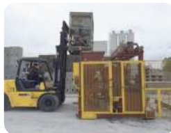
Загрузка бетона в бункер машины
